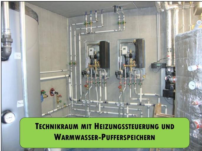
**TECHNIKRAUM MIT HEIZUNGSSTEUERUNG UND
